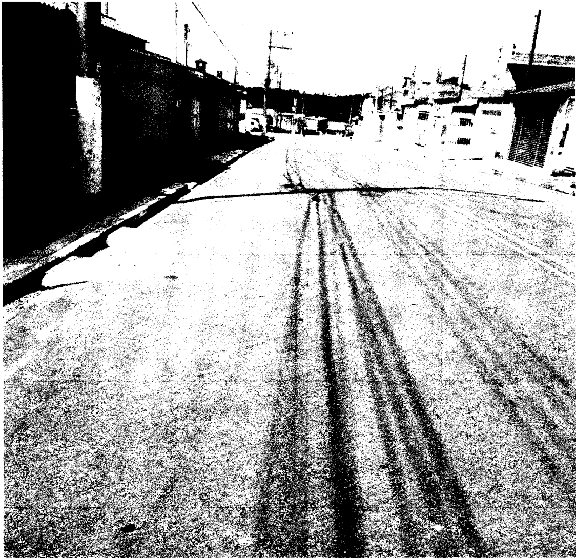
INSTALAÇÃO DE REDUTOR DE VELOCIDADE DO TIPO LOMBADA na Rua Dr. Juca Assi, na altura do número 580 - Jardim Planalto, Mogi das Cruzes.
